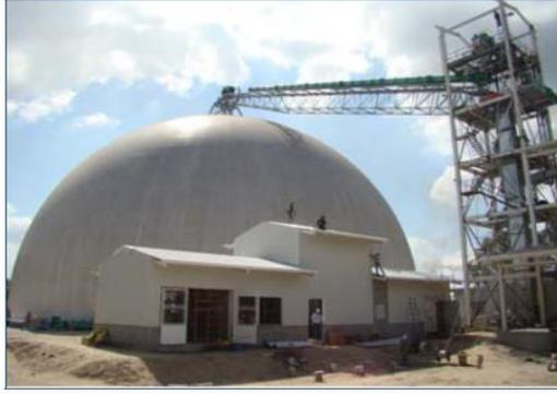
**Foto 1:** Silo domo de 30,000 Toneladas de Ingenio La Unión proporcionada por la empresa constructora.
